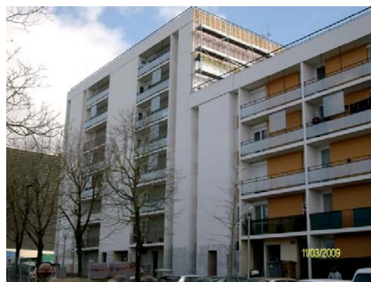
Façades rénovées et nouveaux garde-corps de balcon des bâtiments 22 et 24
